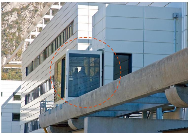
Une collaboration tripartite originale entre le CEA, l'entreprise de transport par câble Poma et Vêpres Constructions : le LETI a construit en 2011 une liaison mobile blanc-blanc entre 2 bâtiments, portée par un funiculaire permettant de transporter personnes et matériels sur 250 m sans rupture de la chaîne d'ultraprotété.
